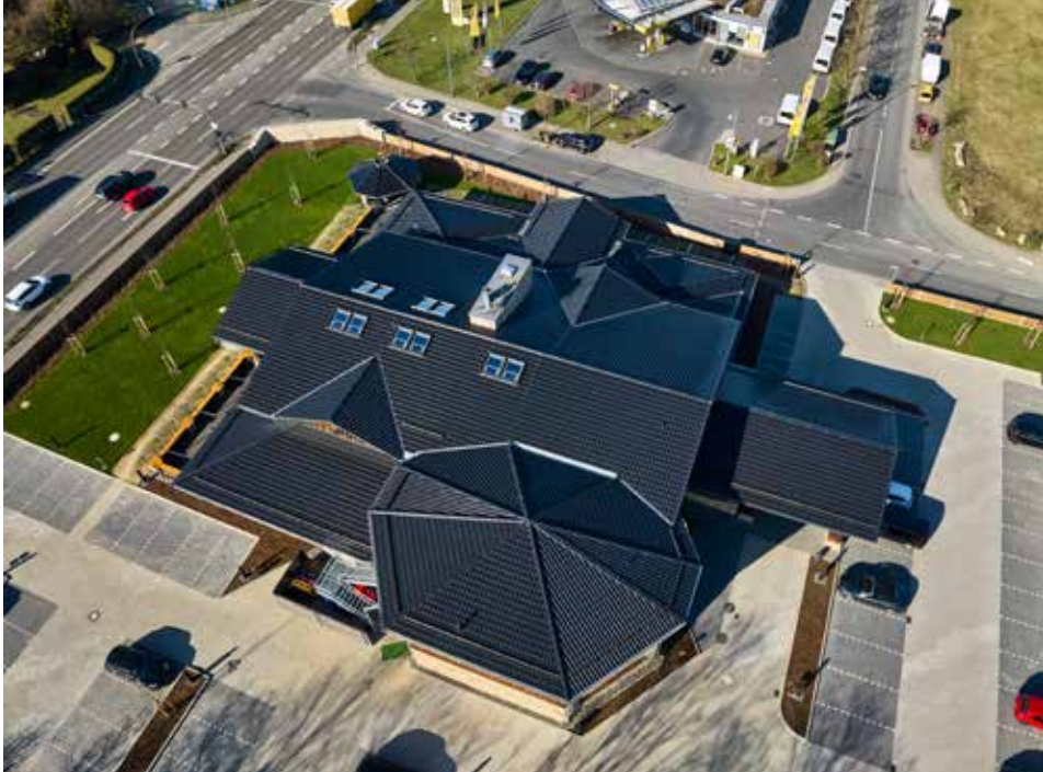
Das fertiggestellte Dach des „Timberjacks“-Restaurants in Köln. Der Neubau befindet sich in einem Industriegebiet unmittelbar an einer Autobahnauffahrt
