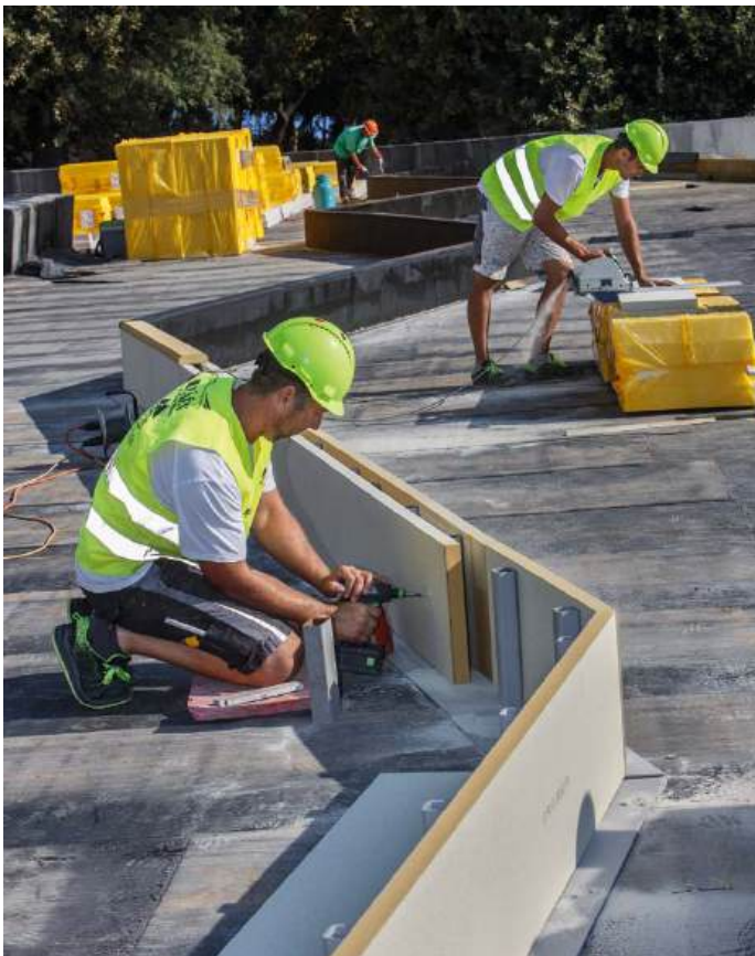
▼ Anschließend wurden die so gesetzten Metallstützen beidseitig mit dem robusten Funktionswerkstoff Purenit beplankt
