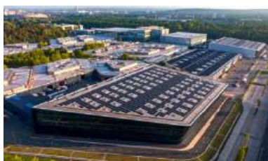
SOLARDACH Messe erzeugt Strom
