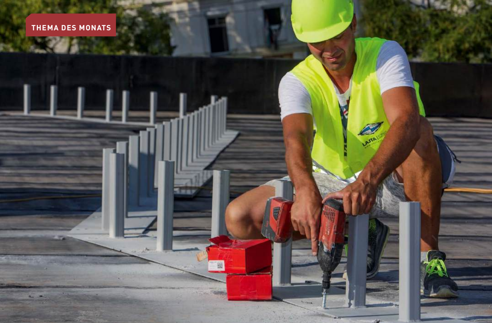
▲ Um Teilbereiche abzutrennen und Schubschwellen anzuordnen, fixierten die Dachdecker Metallstützen durch die Abdichtung in der Dachschale
