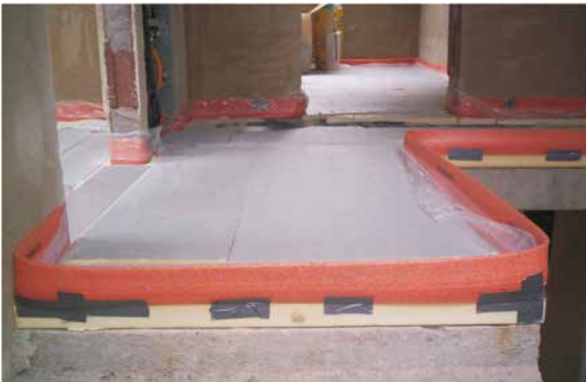
A puren padló-hőszigetelő elemeket, mint például a puen FAL elemeket egyszerű beépíteni és nagyon magas fokú hőszigetelést biztosítanak alacsony szerkezeti magasság mellett.
