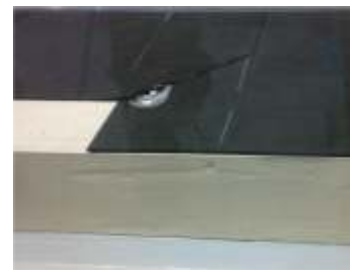
Obr. 8: Két vízzáró réteg átlapolása rögzítéssel
