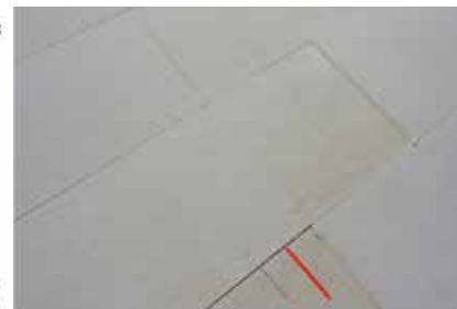
6. ábra: Példa az illesztési fugák tömítettségére
