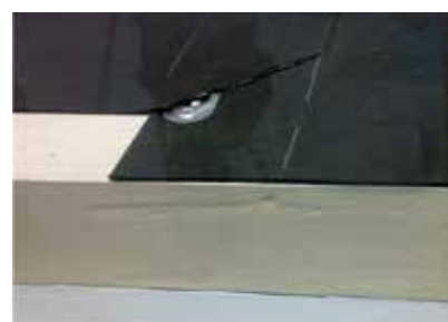
8. ábra: Két vízzáró réteg átlapolása rögzítéssel
