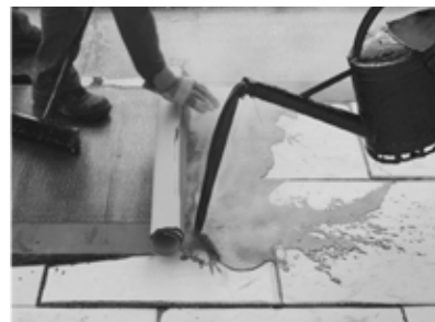
Olvasztott bitumenbe ágyazás
