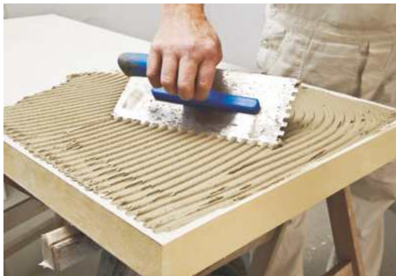
puren izolacija za kletni strop se lahko z lepilom za plošče, kot je epatherm etk, brez težav nalepi tudi na mineralne podlage (masivni strop), obdelane z ustreznim vezivnim premazom, kot je epasit pk.
