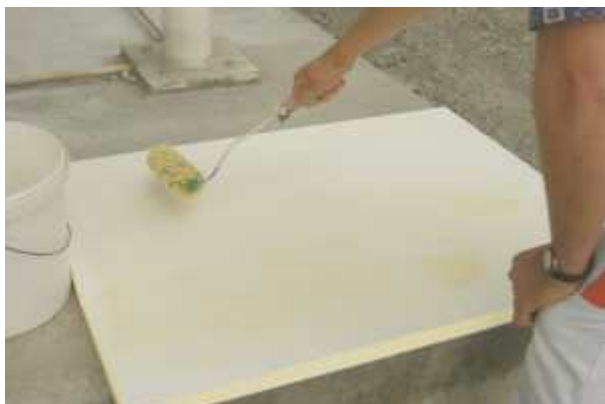
puren izolacija za kletni strop se lahko z lepilom za plošče, kot je epatherm etk, brez težav nalepi tudi na mineralne podlage (masivni strop), obdelane z ustreznim vezivnim premazom, kot je epasit pk.
