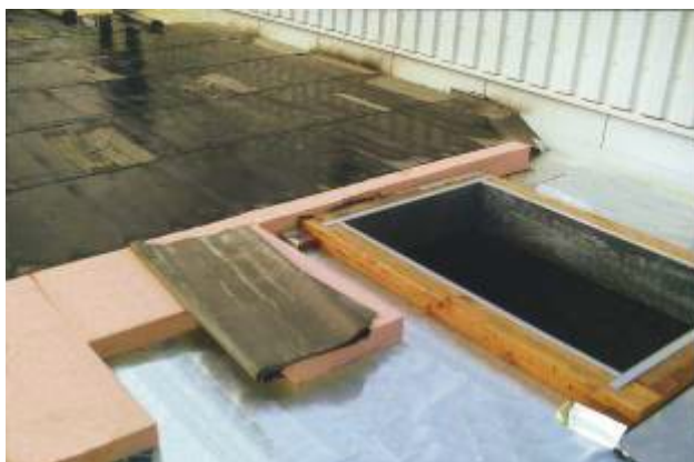
Izolacijske plošče puren® SE-B1 so dobavljive posebej trdne in požarno varne v razredu gradbenega materiala B1 ter C s3 d0 po DIN EN 13501-1.
