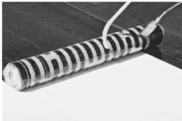
slika: varjenje vmesnega sloja
