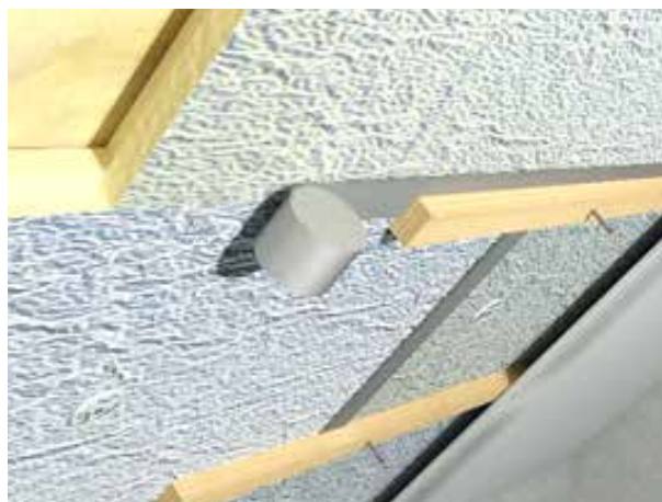
obr.č.6. Vzduchotěsná pokládka izolačních desek. Kotvení izolačních desek puren Compact přes montážní profily do krokví.
